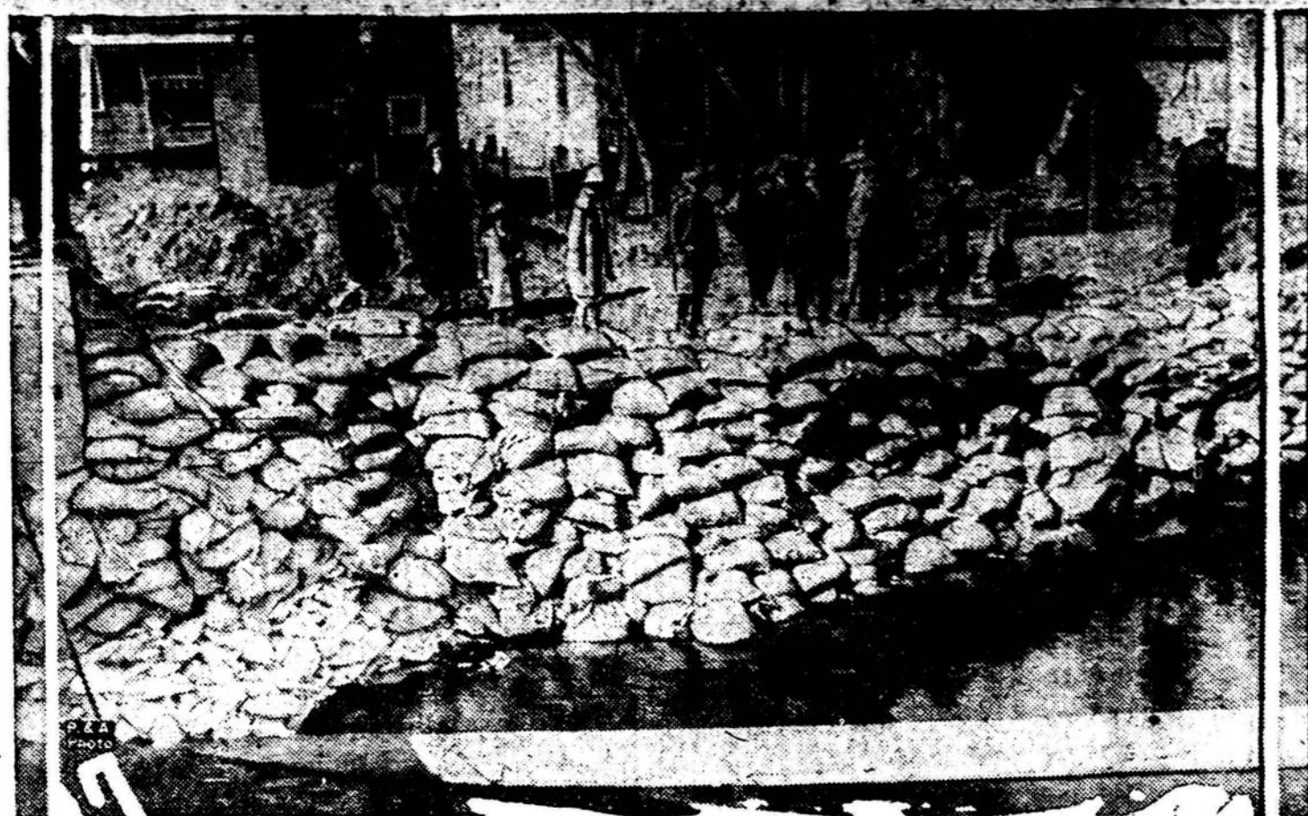
Čia ne duonos kepalai, o smėlio maišeliai. Mieste Portage, Wis. pratrūko pylimas ir miestui buvo pavojus likti užlietam. Bet kas gyvas šoko darban ir inžinieriams vadovaujant per kiaurą naktį dirbo ir granito šmotais ir smėlio maišeliais užtvėnkė plyšį.
