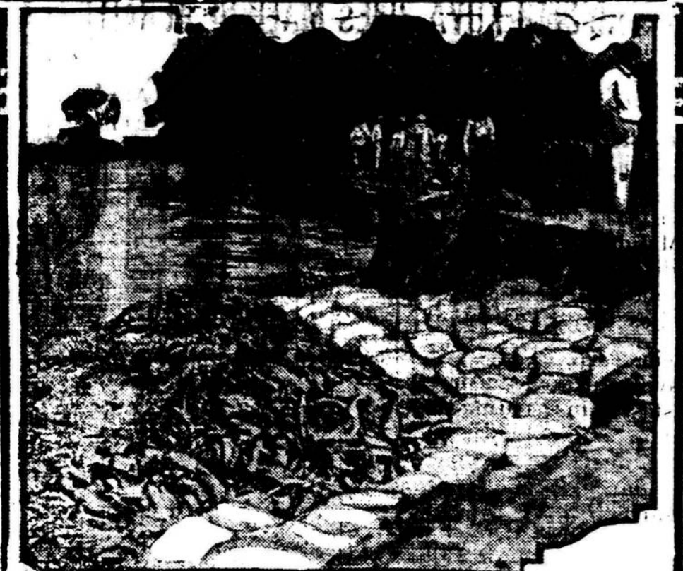
Ties Burlington, Ia. palei upę Skunk pylimas buvo bepratrūkstas. Kad nuo didžio potvinio išsigelbėjus farmeriai rovē žalius kornus, vertę paupin ir ant jų vertė maišukus smėlio. Apylinkės farmeriai dirbo per savaitės laiko. Jiems į talką buvo paleisti ir kaliniai iš valstijinio kalėjimo.
