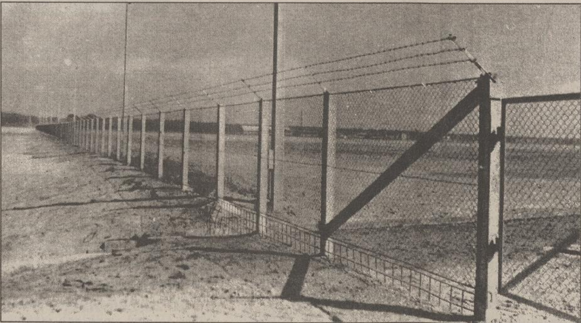
Būtingės naftos terminalo statybai paruošta vieta prie Baltijos jūros.
