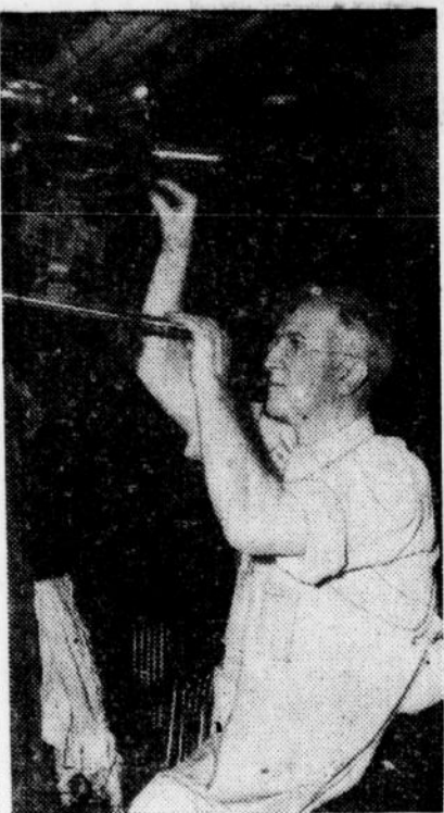
Robert Murray dirba Ilion, N. Y., šautuvų dirbtuvėje tiesindamas šautuvų vamzdžius. Nėra dar mašinos išrastos kuri patėmtų mažiausį vamzdžio netiesumą, kaip šio žmogaus akys.
