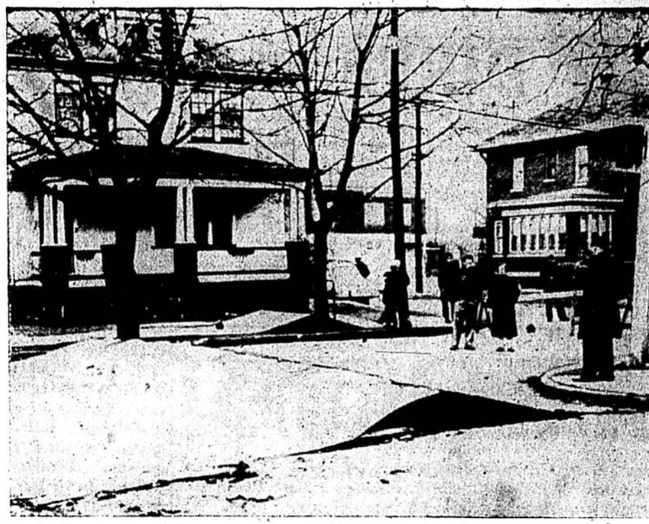
Wilkes-Barre, Pa. įvykęs žemės slinkimas padarė apie $1,000,000 nuostolių. Slinkimas įvyko todėl, kad po 400 pėdų storio žemės sluoksniu yra anglų kasyklos.
