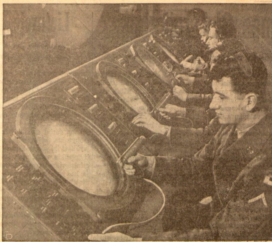
Tai naujos sistemos Nike raketų kontroliavimo aparatai, kurie dabar saugo JAV miestus. Jais surenkamos žinios apie pasirodžiusius prieš lėktuvus ir tuoj perduodamos Nike baterijoms.
