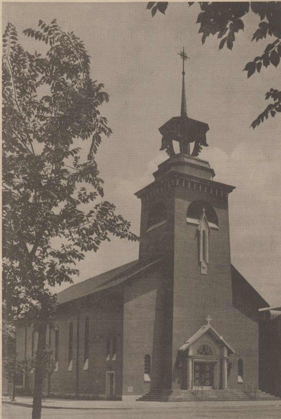
Chicagoje, birželio 16 d., buvo pašventinta Visų Šventų parapijos bažnyčia, kurios projektą darė ir statybą prižiūrėjo arch. dr. S. Kudokas. Statybą vykdė inž. J. Stankus. Jos statybos kaštai siekia beveik pusę milijono dolerių.
