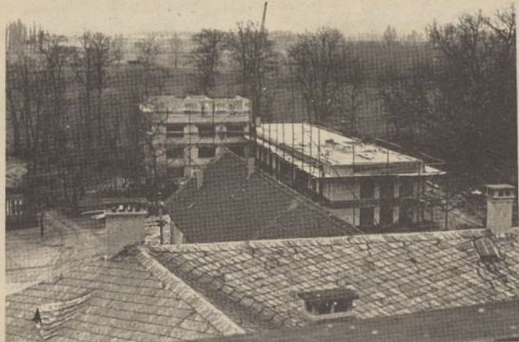
Bendras statybos vaizdas, žiūrint iš gimnazijos bokšto...
