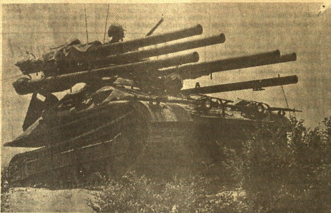
Sėkmingiausias marinių ginklas Vietname yra 'Ontos' -- iš graikiško žodžio 'daiktas'. Čia atvaizduotas 'daiktas' yra apginkluotas šešiomis 106 mm Recoilless rifles ir praktiškai gali sunaikinti bet kokią tvirtinimą. Ontos turi tik marinių korpus.
