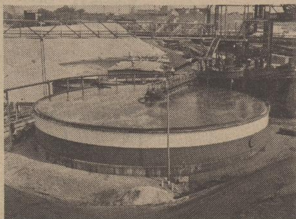
Vienas iš dviejų vandens filtravimo BOF sistemos tankų.
