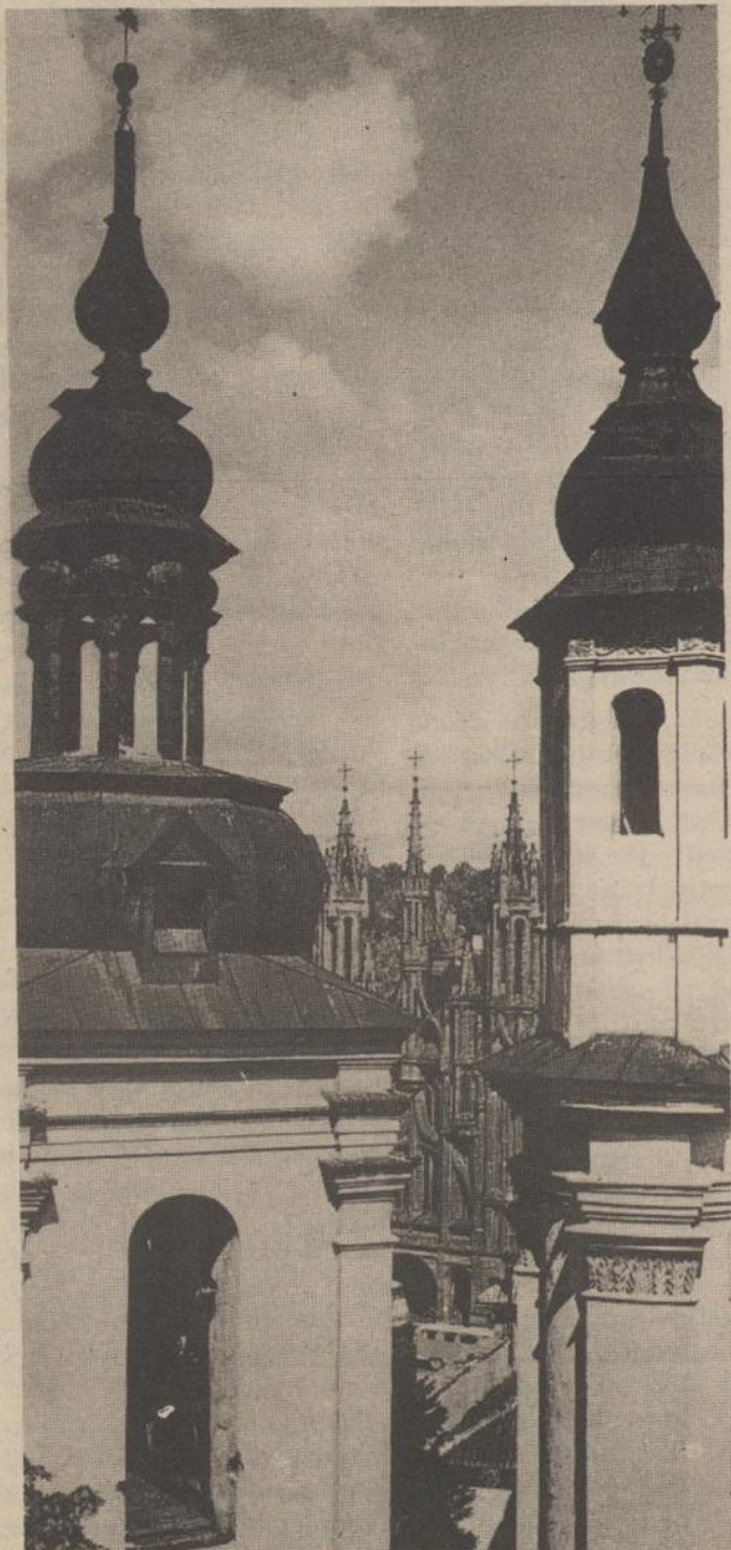
Vilniaus bokštai... Šv. Mykolo bažnyčios (XVII amž.) bokštai.
