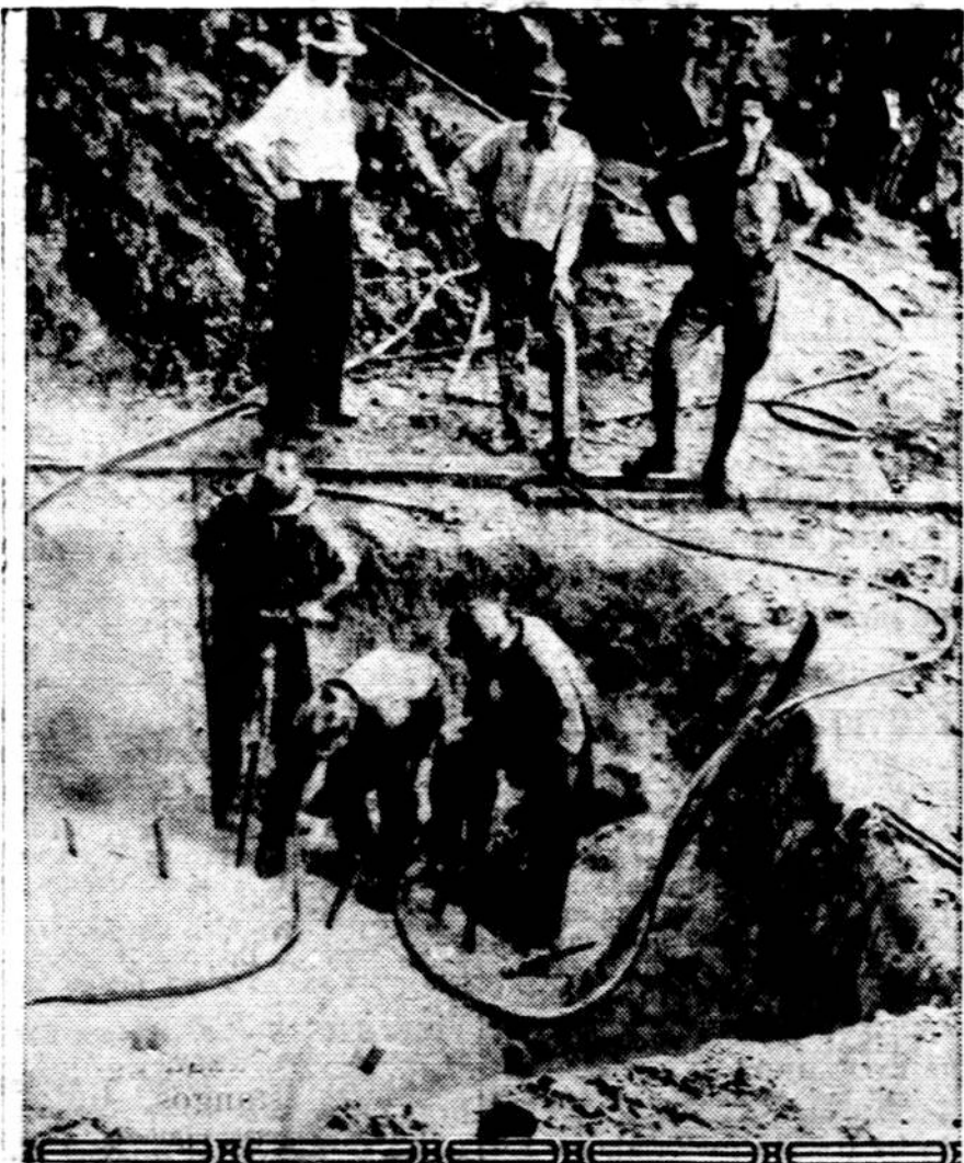
Tennessee valstijoje darbininkai gręžia akmeninę žemę plūta ir paskui dinamitu ją sprogdina, kad paruošus pamatą naujam tvenkiniui prie Clincho upės. Tai vadinasi vis "viešieji darbai", kuriems Kongreso yra paskirta $3.300.000.000.
