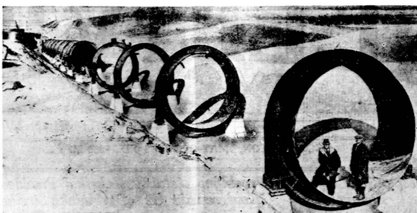
Šitie milžiniški plieno žiedai yra statomi Platte klony per 220 mylių. Juose bus pakabintas tunelis ir tuo tuneliu eis upė į hydro-elektros stotį. Vanduo gamins elektrą ir paskui bus vartojamas sausims Nebraska laukams laistyti. Šį projektą vykina federalinė viešųjų darbų administracija (PWA). Darbas kainuos $7,500,000.
