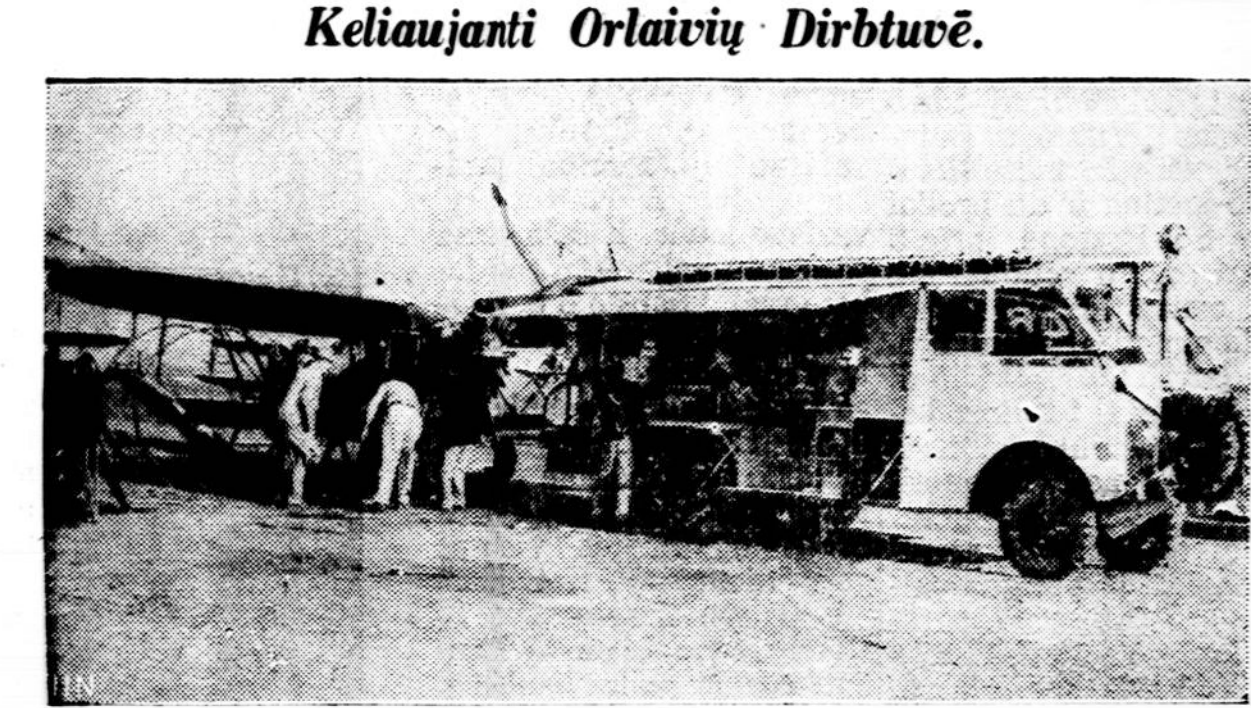
Štai, Amerikoje sugalvota ir pastatyta pirmutinė keliaujanti dirbtuvė orlaiviams taisyti. Ją suplanavo aeronautikos inžinierius Kilby Couse iš Newarko. Ji yra aprūpinta visais įrankiais, reikalingais sugedusiems orlaiviams taisyti. Jos kaina nustatyta $50,000. Manoma, kad tokių dirbtuvių bus galima nemaža parduoti kariaujančioms valstybėms.
