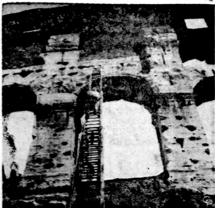
Komoj darbininkas tikrina senovės pastato Kolizejaus sienas, ar labai šalta žiema nepadarė kokios žalos. Tas pastatas per 20 šimtmečių yra pergvenęs net 3 žemės drebėjimus.
