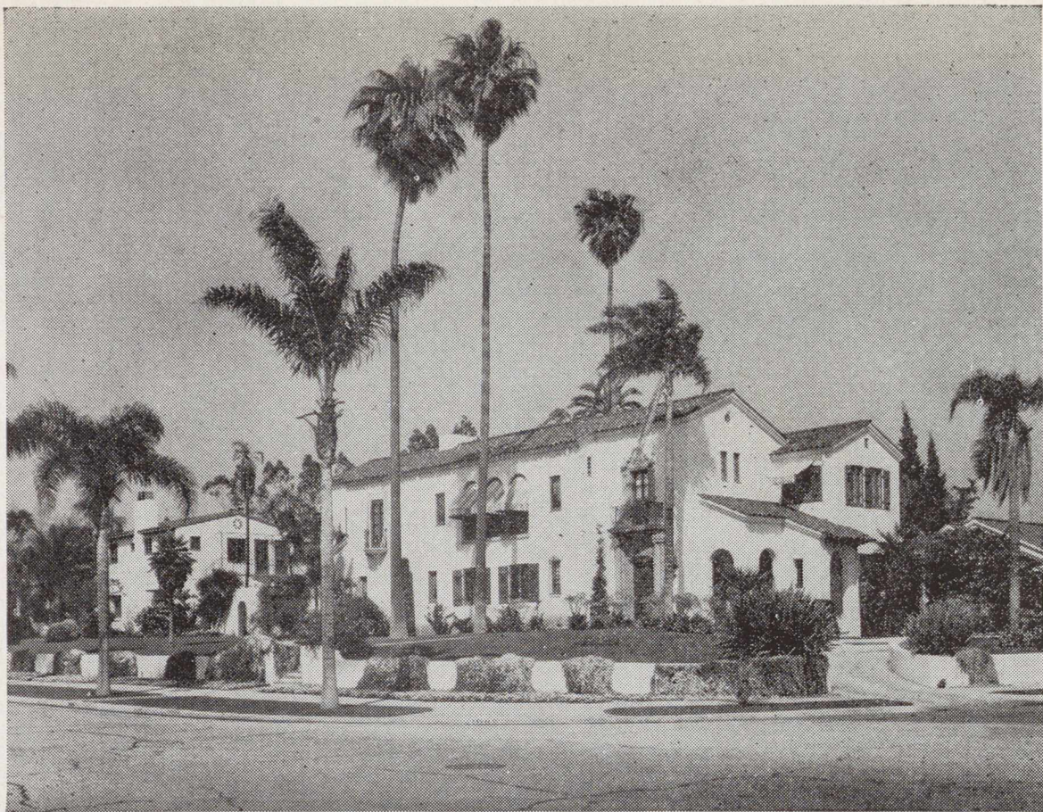
A characteristic Southern California apartment house. / Būdingas pietinēs Kalifornijos vaizdas
