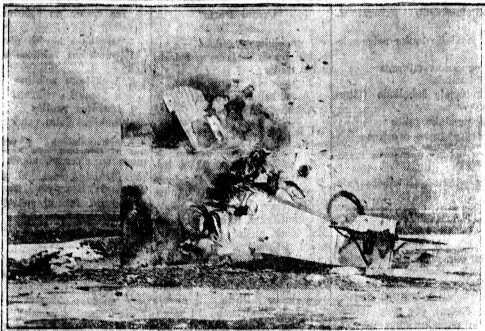
Susidaužęs aeroplanas. Bet aukų nebuvo, kadangi jį tyčiomis sudaužyta armijos tyrinėjimams. Aeroplanas skrisdamas 100 mylių į valandą greitumu atsimušė į mūrinę sieną ir nuo subūrio į šipulius, gasolinas betgi neeksplodavo, nors gasolino aeroplanas turėjo apie 100 galionų.
