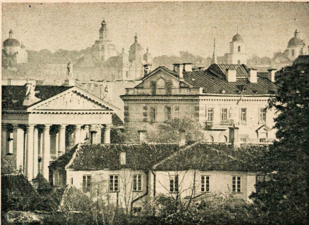
Sostinės Vilniaus bokštai.
