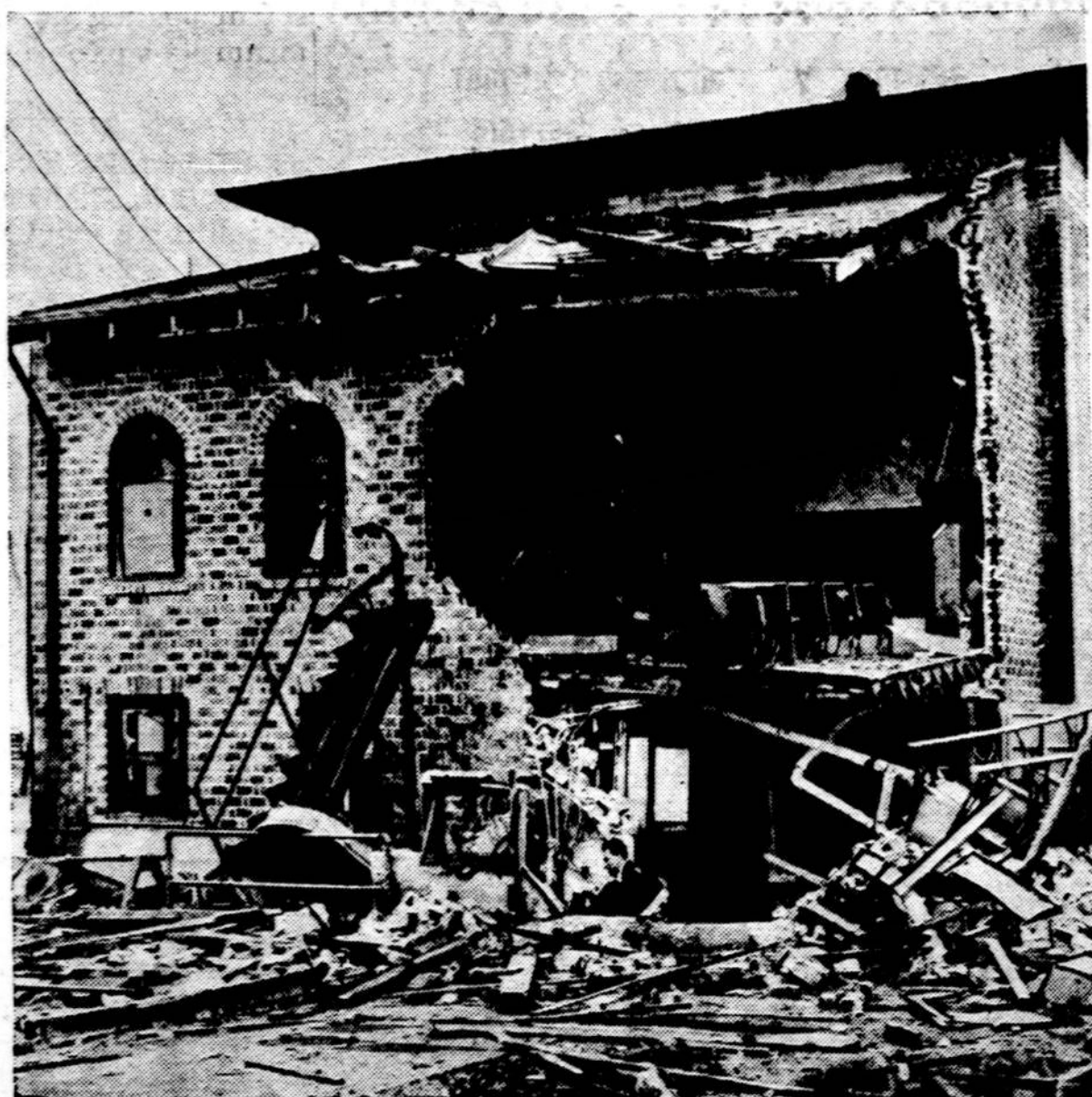
Ši tragedija įvyko Ripon mokykloje, Ripon, Cal., kada eksplodavo peršilęs boileris. Ekspliozija įvyko prieš pat vaikų susirinkimą į mokyklą. Na-mas sudraskytas ir jo skeveldros išnešiotos per pusantro šimto pėdų.
