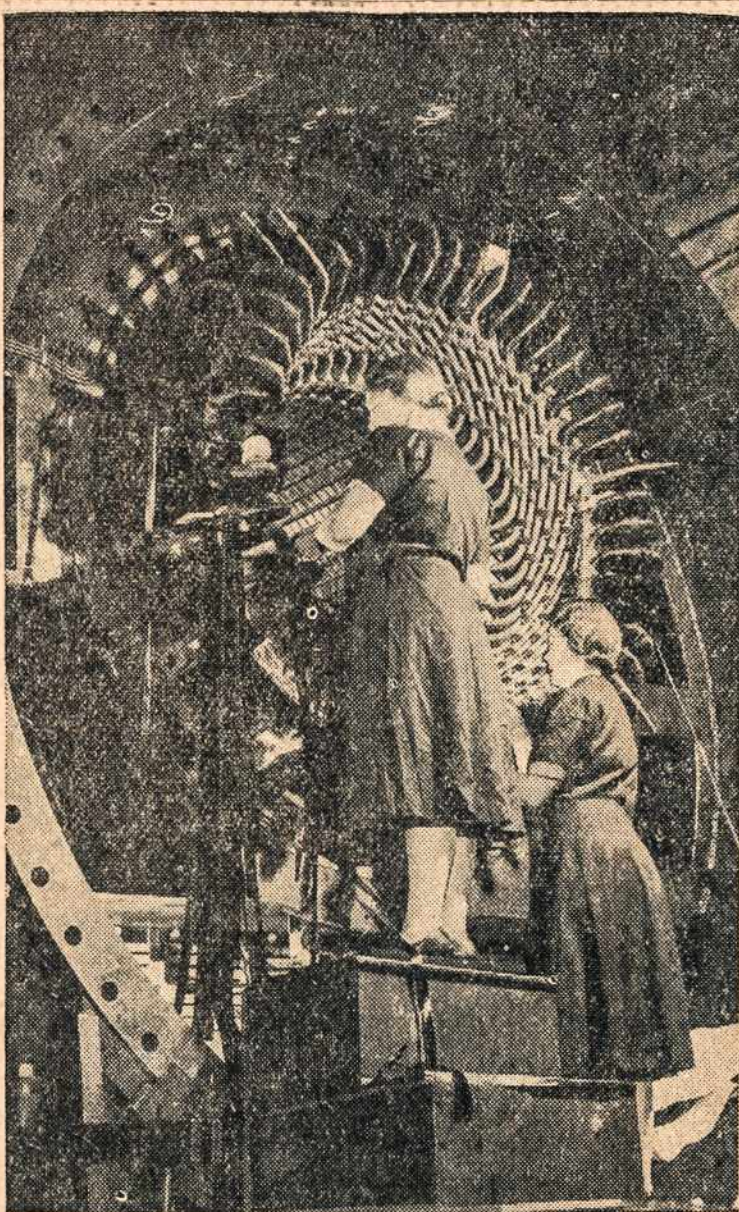
Westinghouse Electric kompanijos įstaigoje, E. Pittsburgh, Pa., moterys pagelbėja pastatyt didžiausį turbininį generatorių, kuris gali išvystyti 65,000,000 watts.
