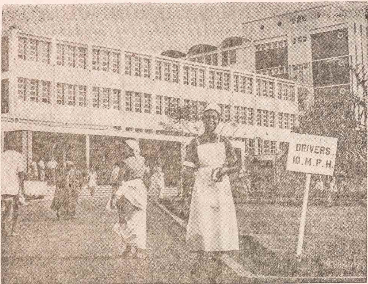
MODERNISKA ligoninė Ghanoje, statyta užsienio kapitalu.
