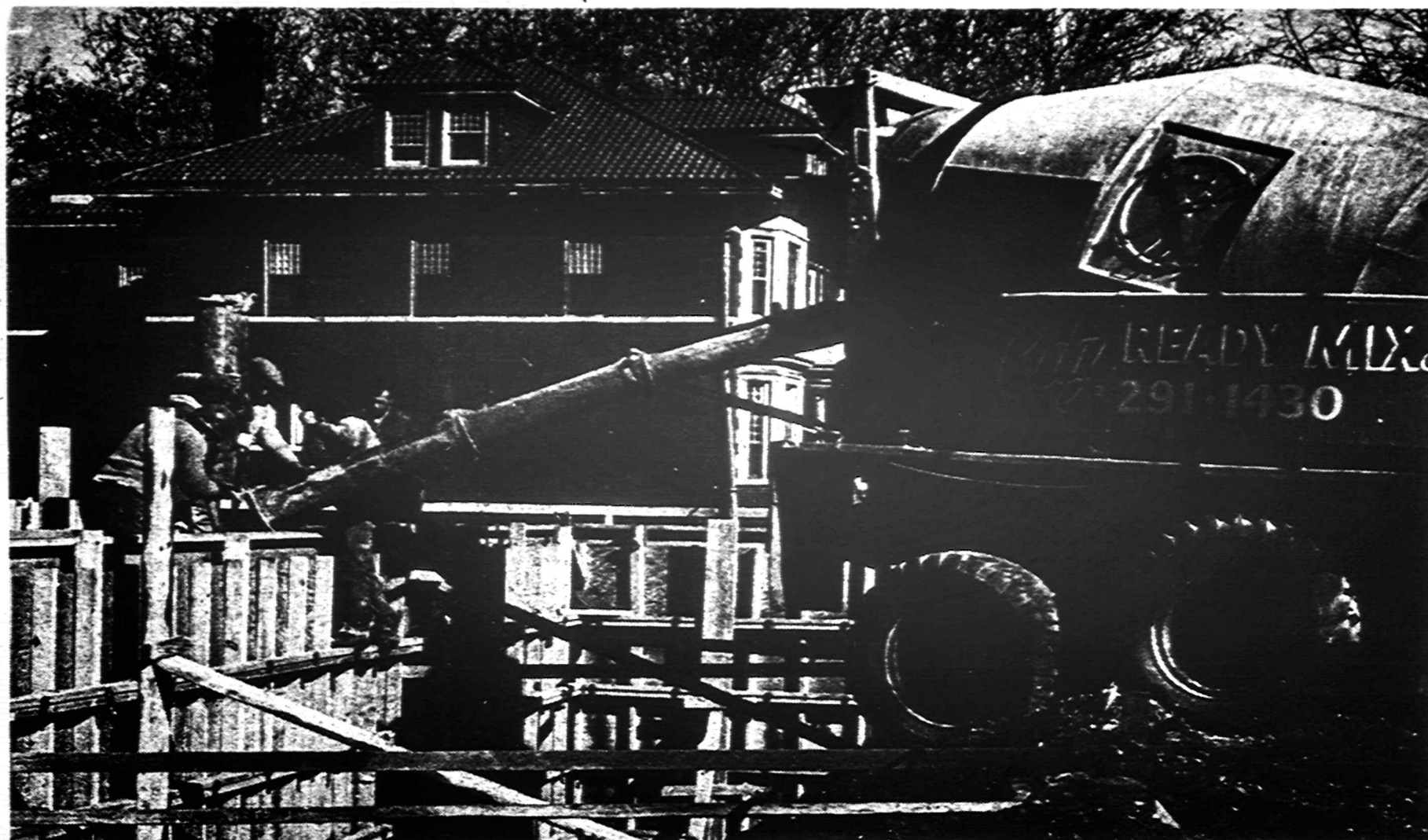
Kultūros Židinio statyba, nežiūrint blogo oro, buvo tęsiama ir praeitą savaitę. Pilamas cementas į pamatų sukalts formas. Nuotr. P. Bivainio.
