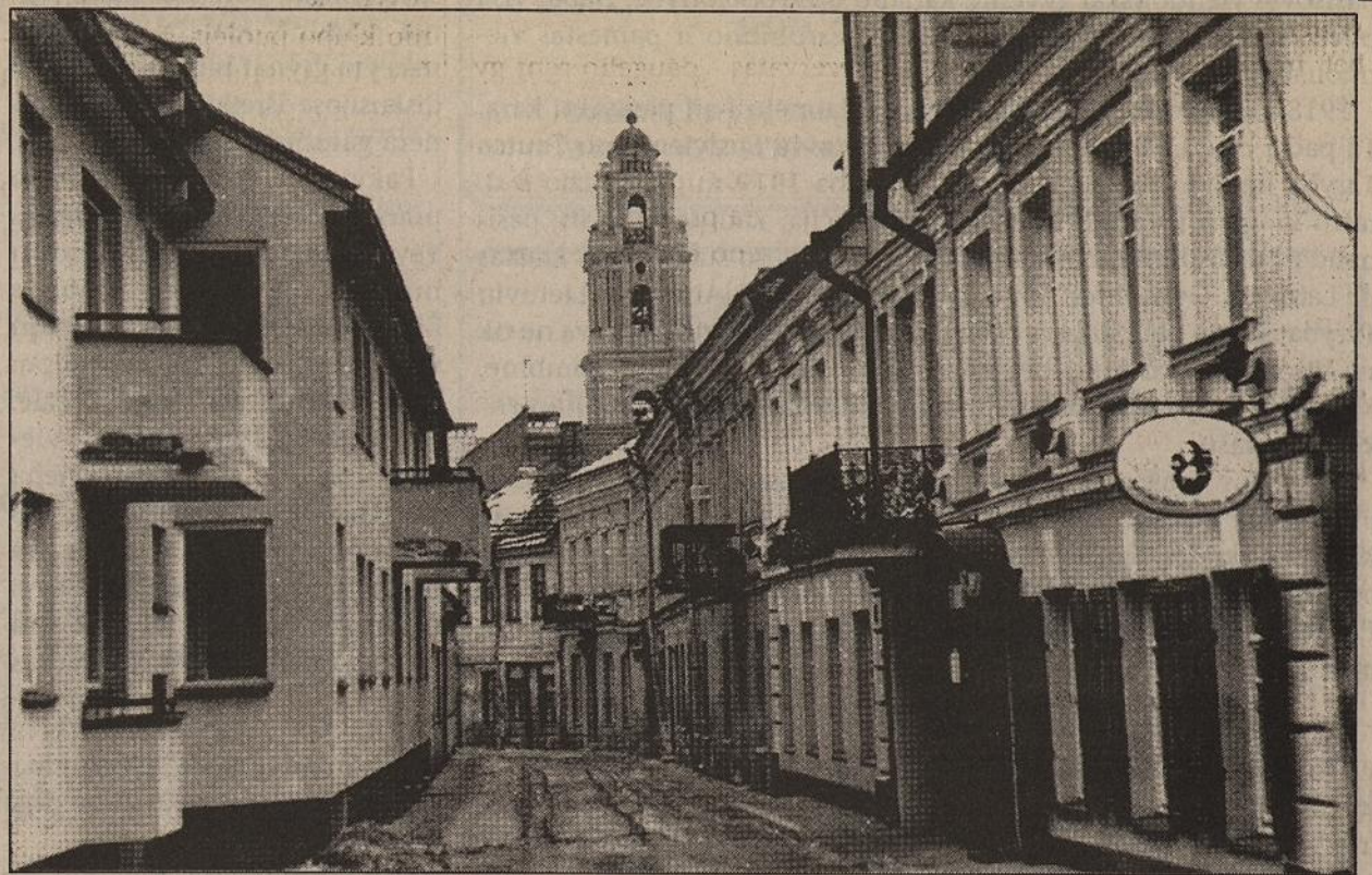
Restauruojamas Vilniaus senamiestis tampa kultūriniu ir prekybiniu sostinės centru
