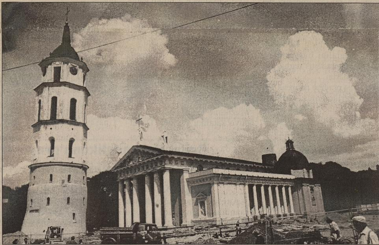
Restauruojama katedros aikštė
