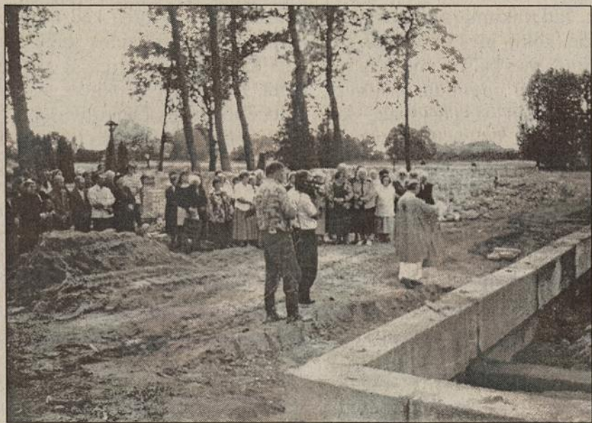
Žvirgždaičių bažnyčios pamatų šventinimas
