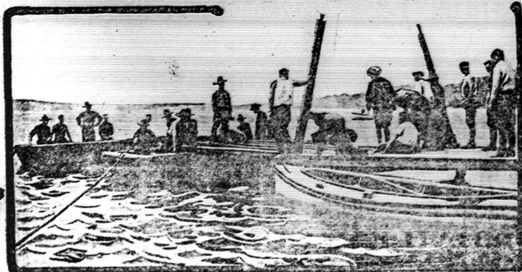
Inžinerijos studentai tiesie tiltą.
