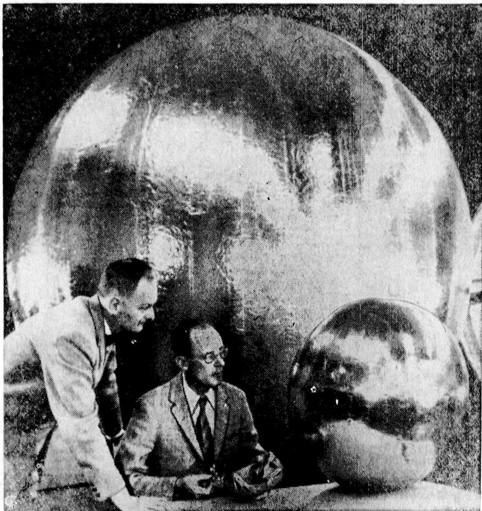
Vaido užpakaly 12 pėdų aliuminio balionas, kuris bus naudojamas naujai projektuojamam JAV satelitui. Jupiter raketa jį iškels nepripusią, po to jis automatiškai prisipūs ir skris apie žemę. Jo amžius bus labai trumpas, bet švies kaip pirmos raišies žvaigždė.
