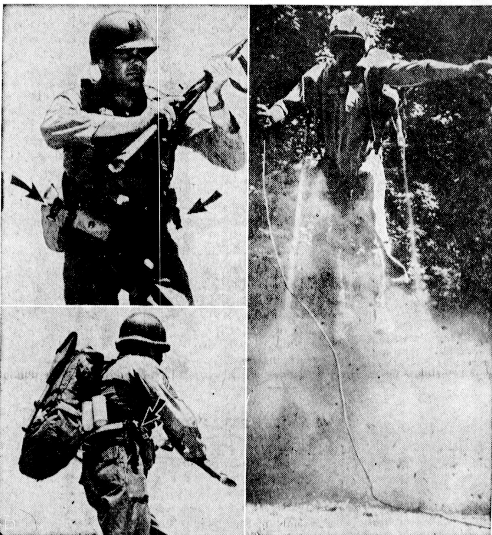
Ateityje pėstininkai galės atlikti didelius šuolius į kalnus, per upes ir pelkes bei pasiekti lenktyninio arklio greitį, užsidėję specialų diržą su 2 mažais raketiniais varikliais (žiūr. strėles). Nuotraukoje matomas JAV karys per pirmuosius bandymus galėjo nušokti 20 pėdų į tolį.
