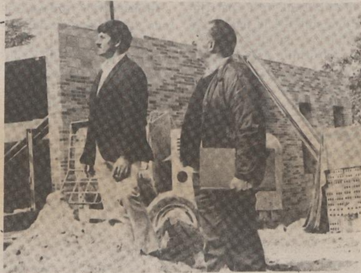
1971 metų rudenį statybos darbų peržiūra — iš kairės gen. kontraktorius Linas Staškūnas su pirm. Juozu Stempužiu.
