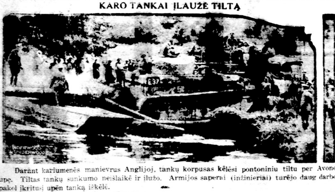
Darant kariumenės manevrus Anglijoje, tankų korpusas kėlėsi pontoniniu tiltu per Avono upę. Tiltas tankų sunkumo neislaikė ir ilužo. Armijos sapera (inžinieriai) turėjo daug darbo pakel įkritusį užen tanką iškelė.
