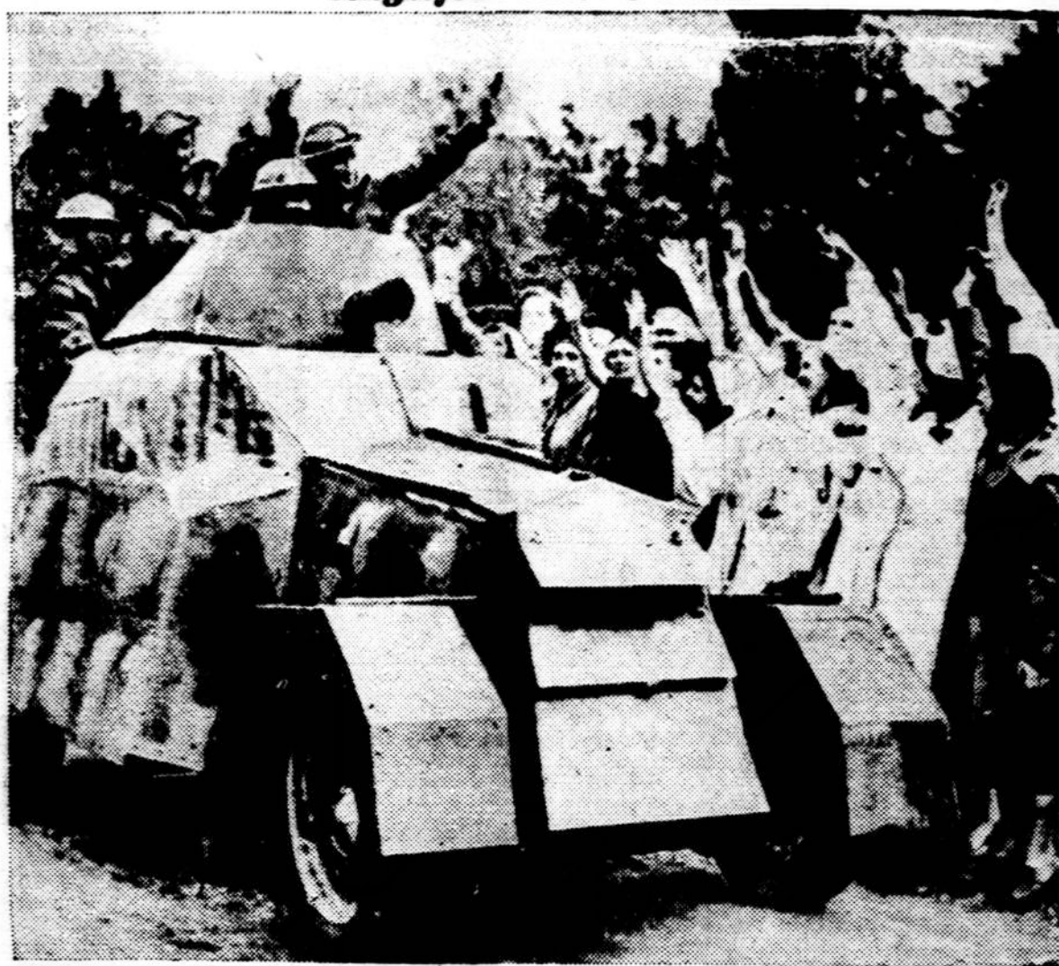
Iš senų automobilių Anglijoje dabar daromi šitokie karo vežimai, kaip matosi šiame vaizde. Jie apsaugoti senomis plieno plokštėmis ir apinkluoti aukšto kalibro kulkas vaidžiais. Jie yra taikomi gatvių kovai su įsiveržusiu priešu.
