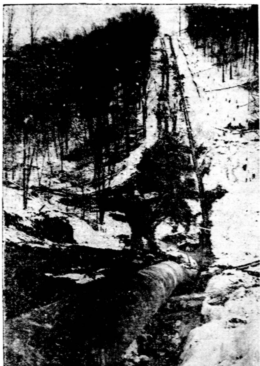
Vaidzdis parodo didžiąją ryna, kuri dabar yra tiesiama per Pensilvanijos kalnus. Ta ryna bus pumpuojamas aliejus iš pietinių ir rytines valstijas. Darbą labai trukdo baurūs orai.
