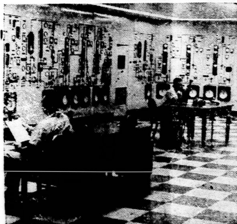
Kontrolinės lentos operatoriai kontroliuoja cheminį procesą viename Du Pont fabrikyje. Informacija iš šio nervų centro duoda nurodymus dešimties technikų ir darbininkų įvairiose dirbtuvės dalyse.
