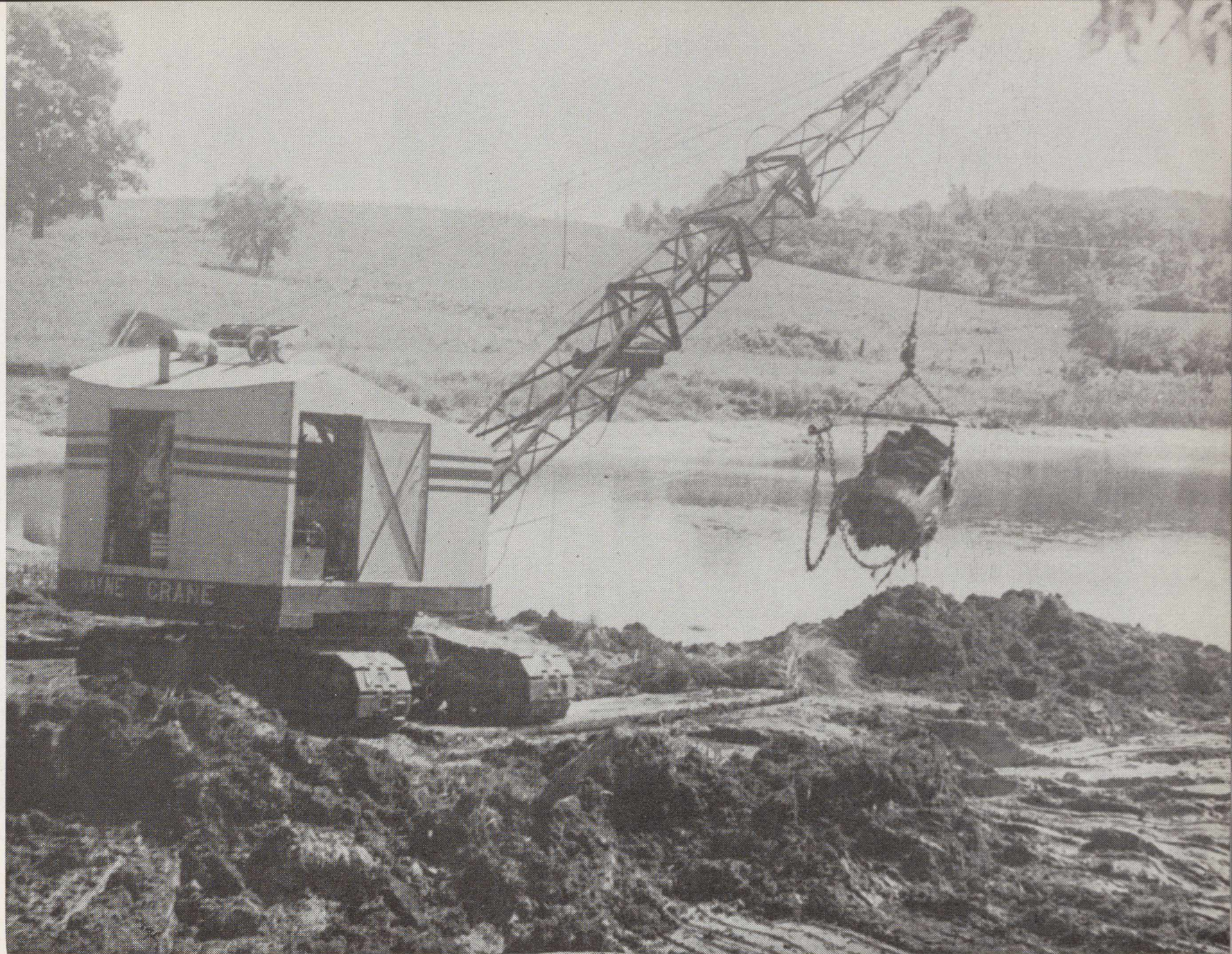
Kelio į jaunimo stovyklavietę statyba. Perna pavasarį pradėta kelio statyba pareikalavo gilių iškasimų ir ukštų pylimų.
