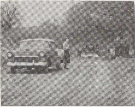
Kelio į jaunimo stovyklavietę statyba. Perna pavasarį pradėta kelio statyba pareikalavo gilių iškasimų ir ukštų pylimų.
