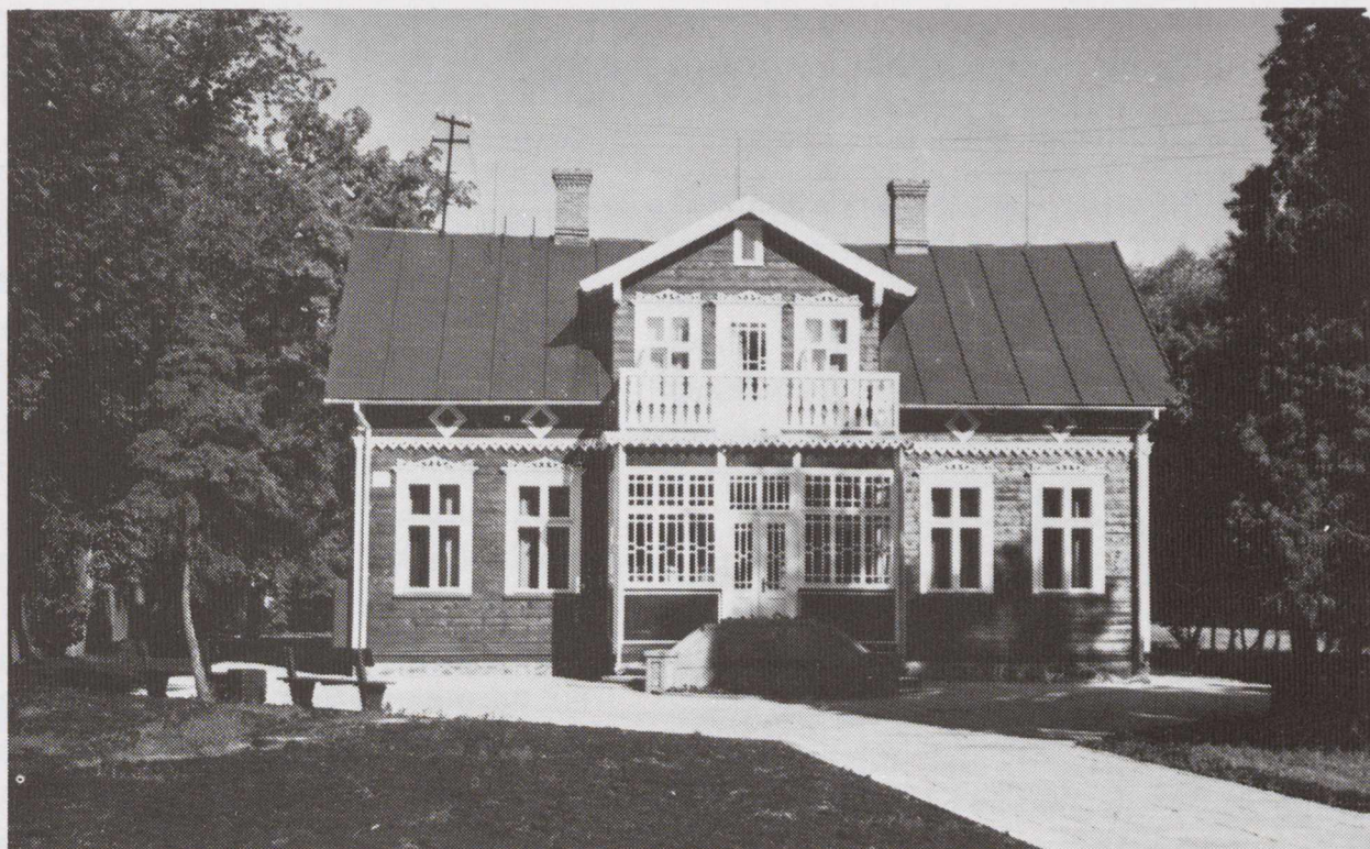
The repaired house of aušrininkas Dr. Jonas Sliupas, Palanga, 1989. Atremontuoti aušrininko dr. Jono Šliūpo namai Palangoje, 1989.
