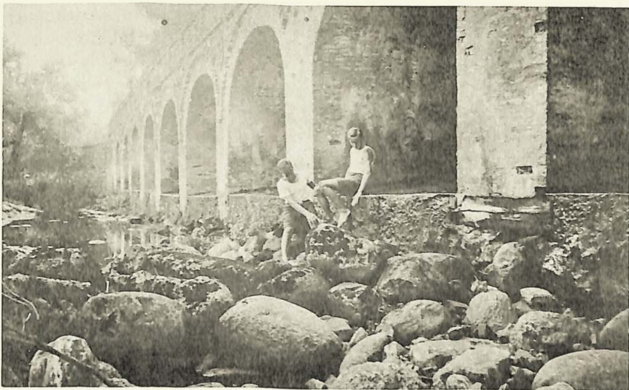
Tiltas, kuris laiko užtvėnkęs Biržų ežero vandenį. Į ežerą įteka dvi upės: Apaščia ir Agluona. Ežeras yra antroje pusėje šio tilto, pro kurio angas būna nuleidžiamas vandens perteklius. Tiltas pastatytas baudžiavos laikais.
