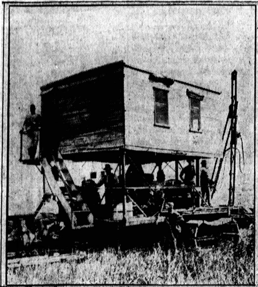
DARO KELIĄ. — Ypatinga prietaisa, kuri užvaria savy traktorių, kujų, suspausto oro grąžta ir butą darbininkams gyventi. Ši prietaisą vartojama skiniui kelio per Everglades raistus Floridoj, kur bus pravestas naujas geras Tamiami cementuotas kelias.
