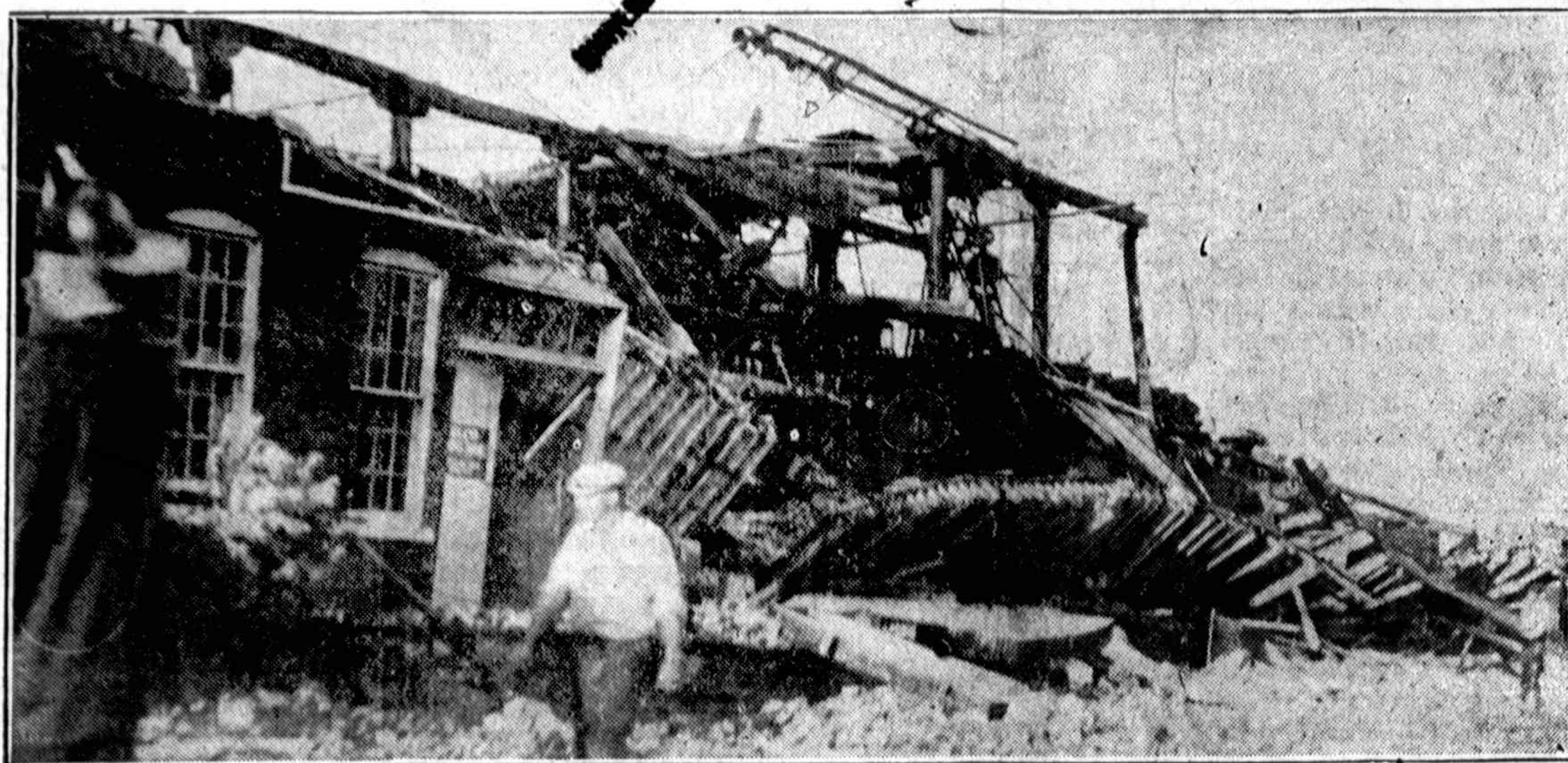
Ką padarė tornadas Rockforde, Ill., rugsėjo 14 dieną. — Sugriautas Elso Tool kompanijos fabriko trobesys. Katastrofoje kele-tas žmonių buvo užmušta ir sužeista.
