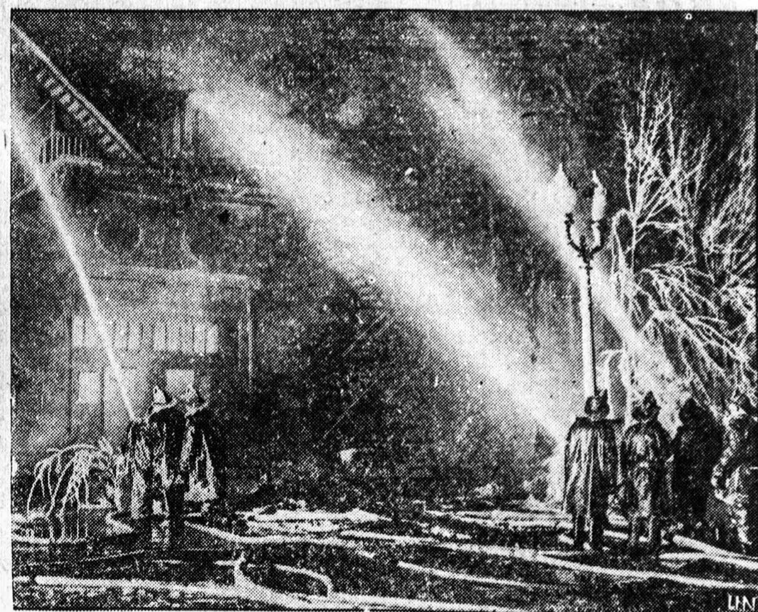
DETROIT, MICH. — DEGA WESTERN AUKŠTESNIOJI MOKYKLA (high school). Apskaičiuojama, kad gaisro nuostoliai sieks $1,000,000. Gaisras, sakoma, kilęs dėl sugedusių elektros vielų.
