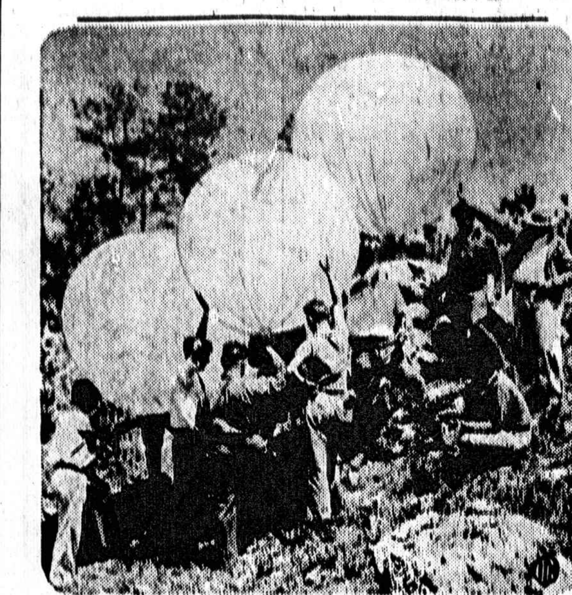
Beisruošiant prie skridimo į stratosferą didžiausiu ballunu iš daubos ties Rapid City, S. D., buvo paleisti trys maži ballunai į stratosferą. Jie buvo aprūpinti automatišku radijo ir buvo pasikėlę iki 61,000 pėdų aukštumos.
