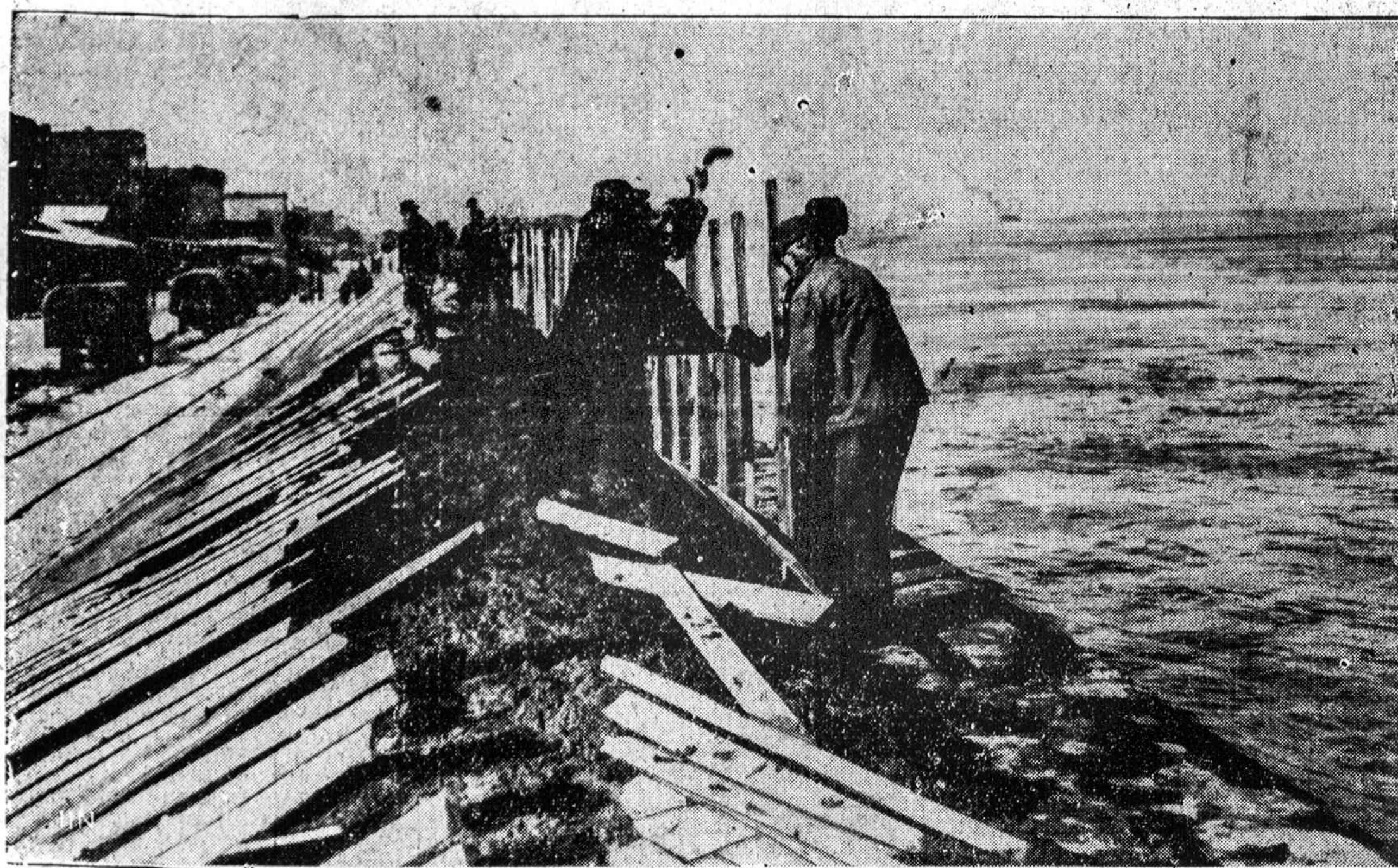
2.—STIPRINA CAIRO SIENĄ — Darbininkai Cairo mieste skubiai dirba statydami trijų pėdų sieną ant pylimo, kad apsaugoti miestą nuo vandens. Naujienu-IIN Photo
