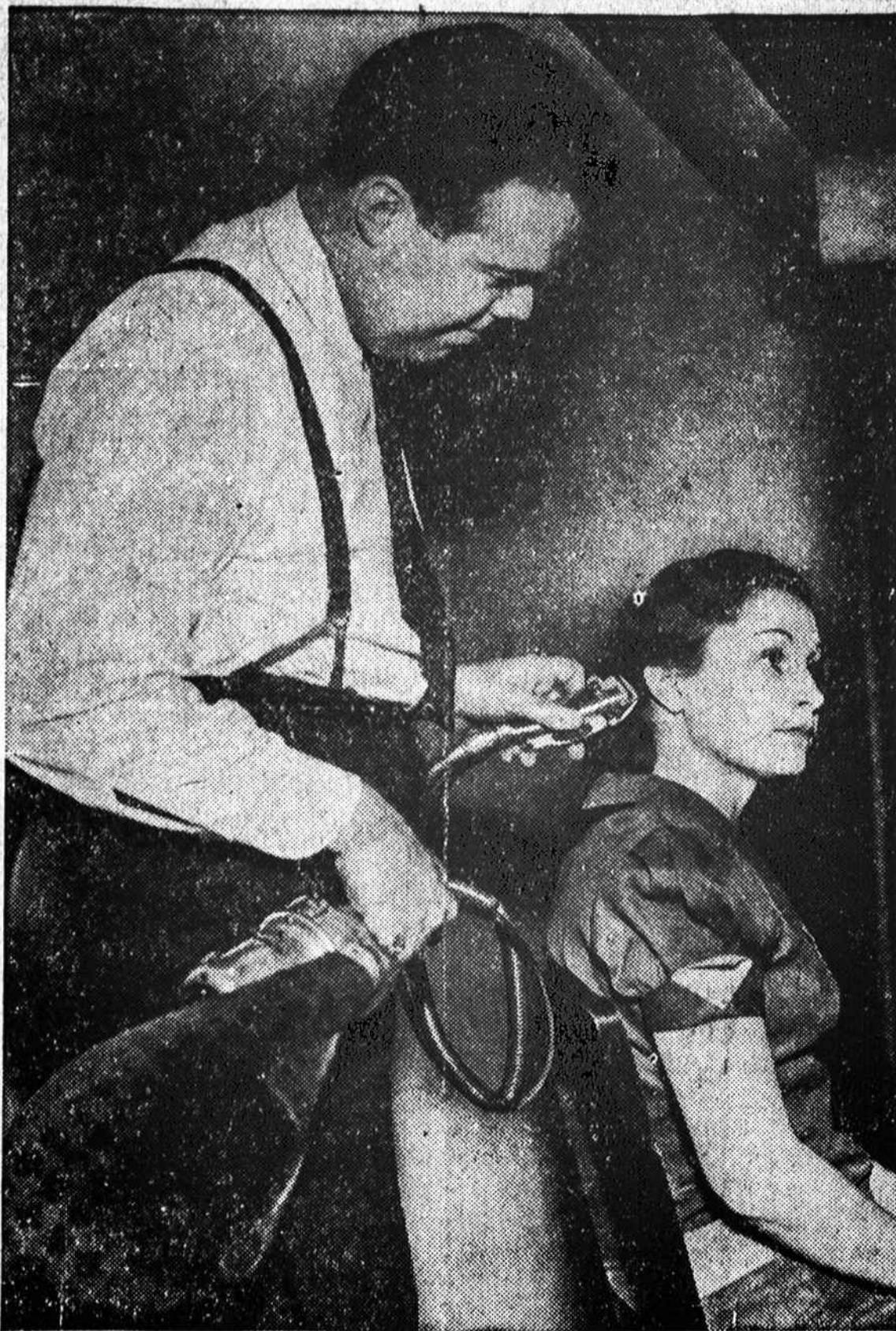
LOS ANGELES, CAL. — Išradėjų kongrese demonstruojamas naujas prietaisas plaukams kirpti. Nukirpti plaukai yra sutraukiami į maišą, todėl nereikia nuolat grindų šluoti.
