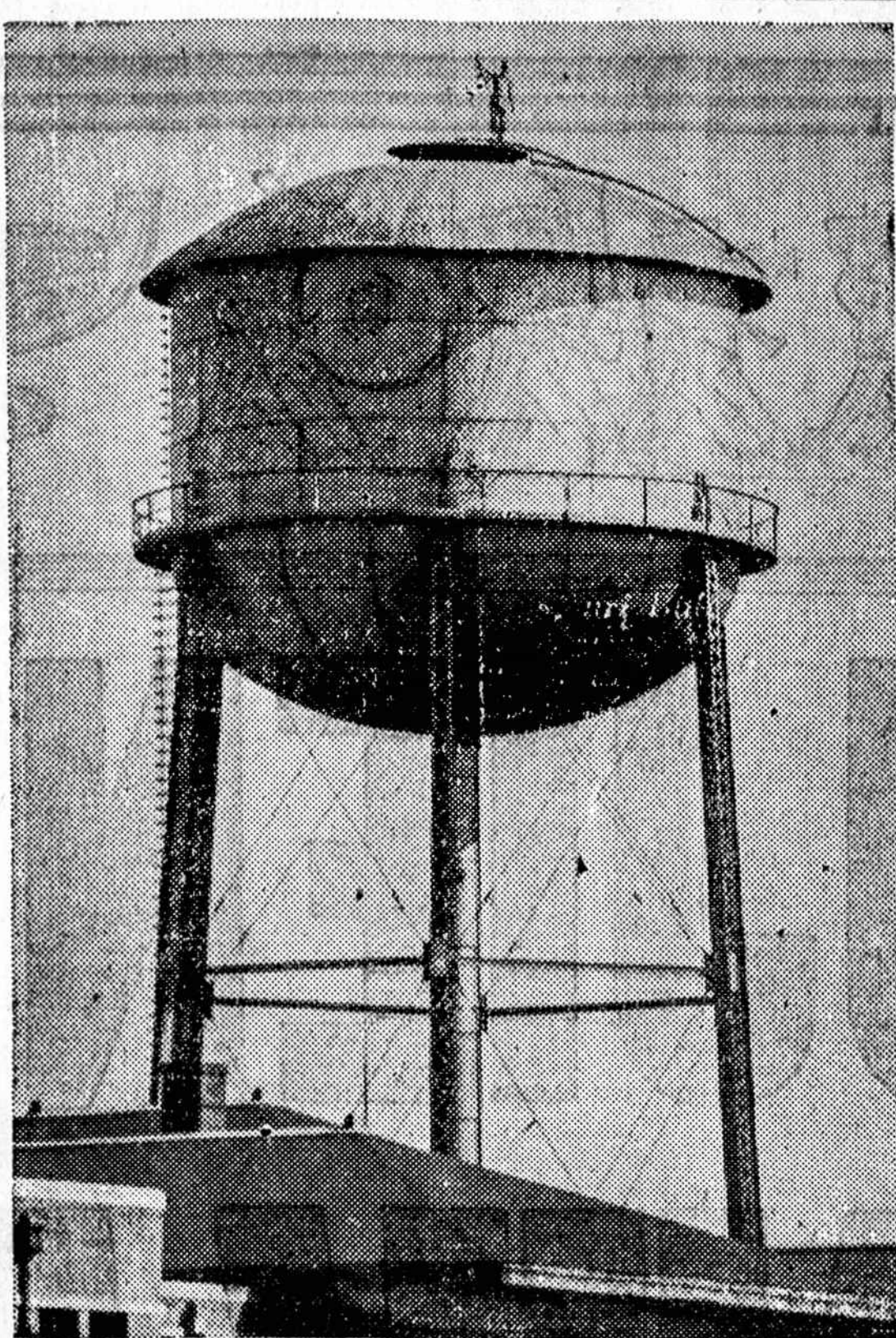
Andrew J. Wynne užsilpo ant Atlanto federalio kalėjimo vandens tanko, grumodamas šokti žemyn, jei bus bandoma jį perkelti i Georgia kalėjimo stovyklą.
