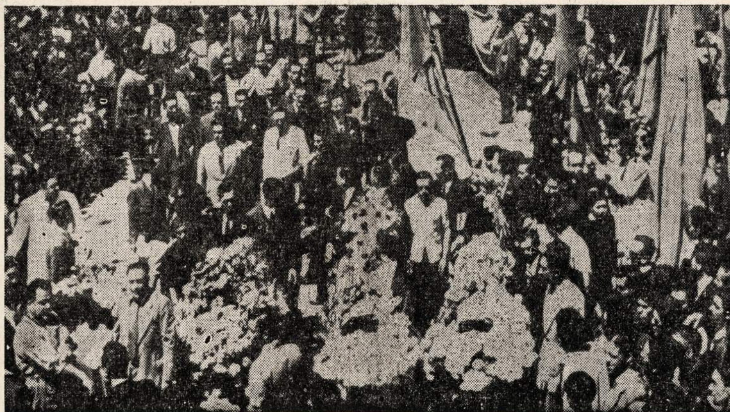
SANTIAGO, CHILE. — Laidojamos riausių aukos. Riaušėse žuvo 7, o sužeistų skaičius siekia 100. Riaušės kilo ryšyje su pasimojimu panaikinti darbininkų unijas.
