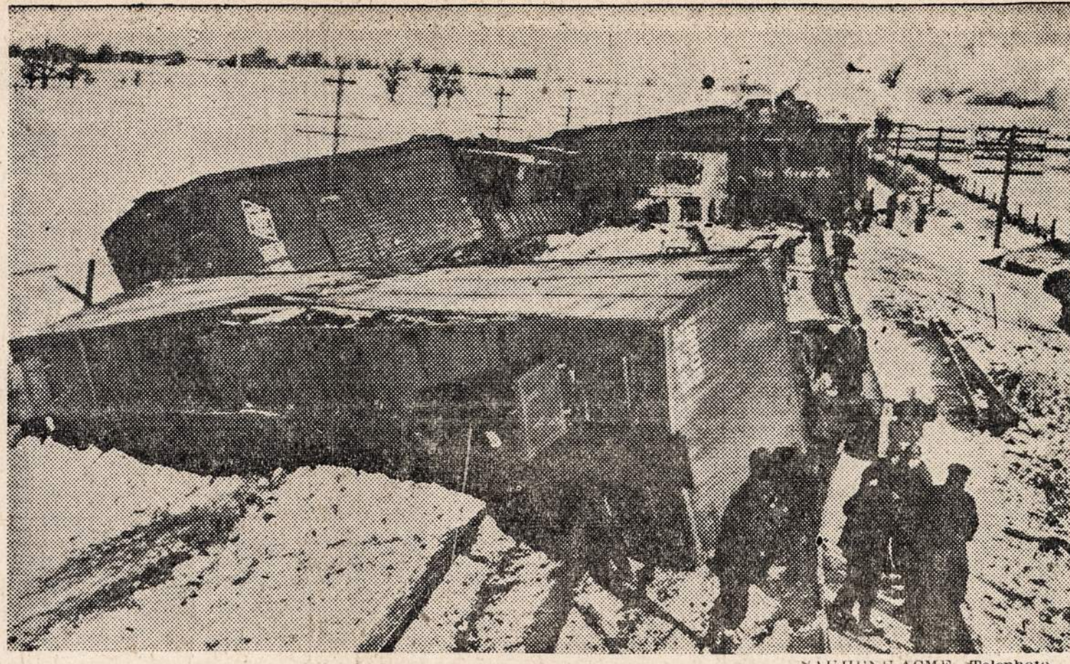
Nulužus vieno vagono ašiai, ties Racine, Wis., nuo bėgių nuvirtlo 1 vagonas. Nelaimės metu nenukentėjo nei vienas žmogus.
