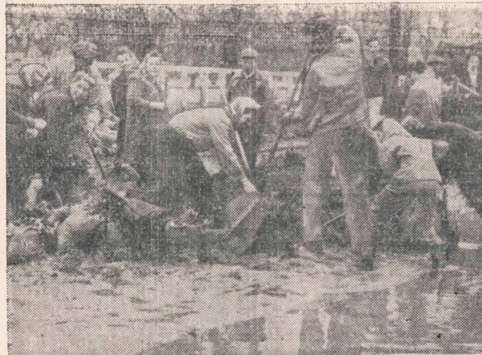
Wabash upės vanduo pakilo, išsiliejo ir padarė didelių nuostolių. Paveikslė matome Vincennes, Indiana, srityje dirbančius darbininkus. Jie bando sustiprinti užtvankas, kad neprasiservėtų daugiau vandens.
