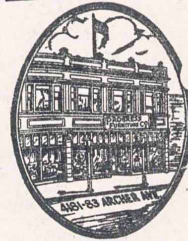
PROGRESS Krautuvės Namai
