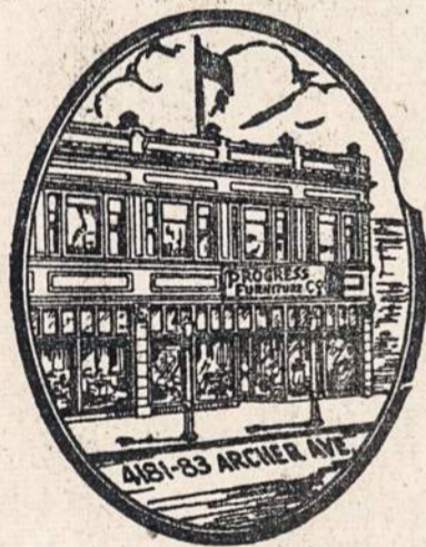
PROGRESS Krautuvės Namai
