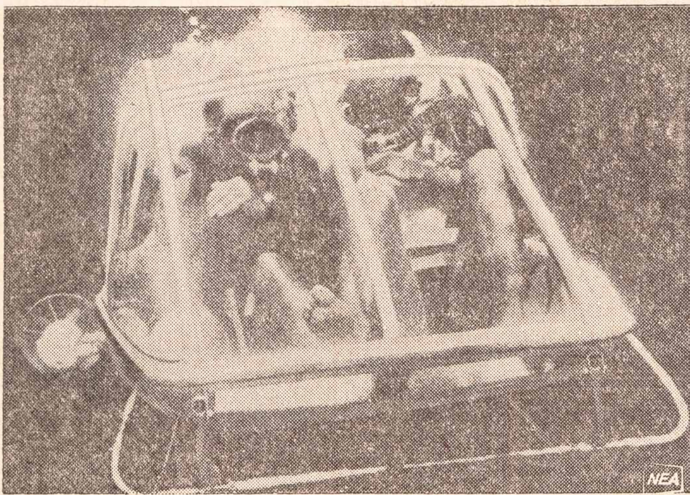
Sovietų karo vadovybė pastatė lengvą narlaivį, kuriuo du žmonės gali gana giliai nusileisti. Pa-veiksle matomas narlaivis pastatytas iš aliuminijaus ir plastikinės medžiagos. Jis buvo išbandy-tas Juodojoje jūroje. Sovietų valdžia rengiasi daugiau tokių narlaivių pastatyti.
