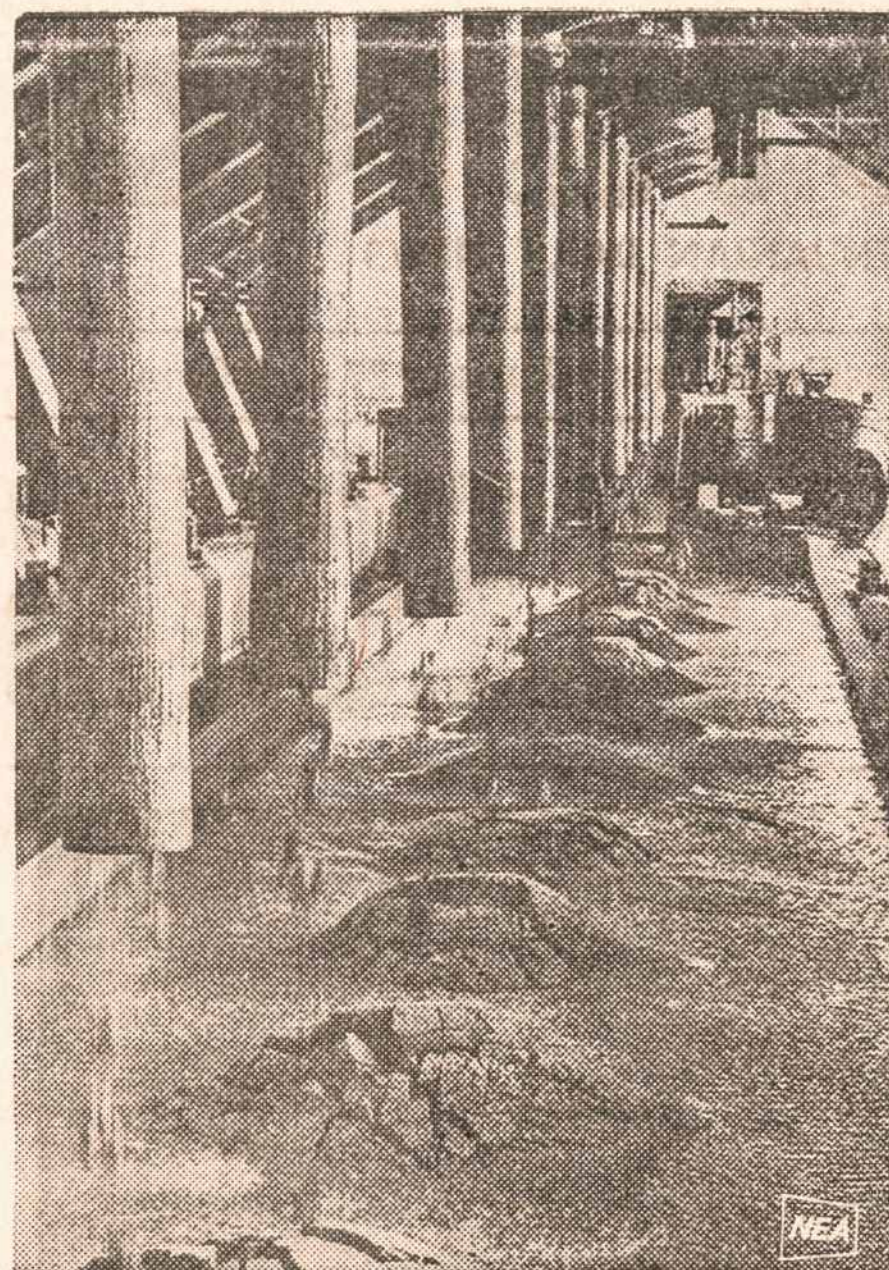
Statybai smėlį olandai ima iš jūros pakraščiu. Paveiksle matome olandų prietaisus smėliui iš dugno pakelti, jį išvalyti nuo įvairių druskų, kad jis tiktų statybai.
